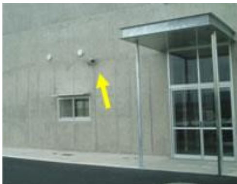
図 3-3 出入口を監視する防犯カメラ
