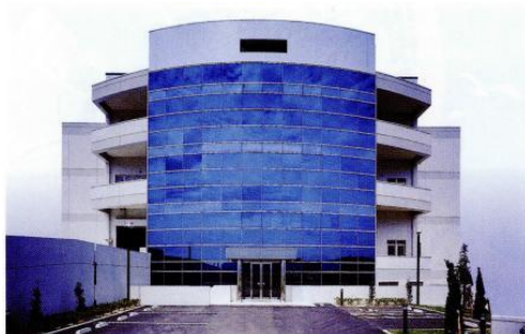
写真 10 坂出市リサイクルプラザ
