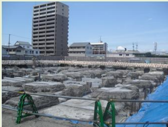
掘削工事、杭頭処理が完了しました
