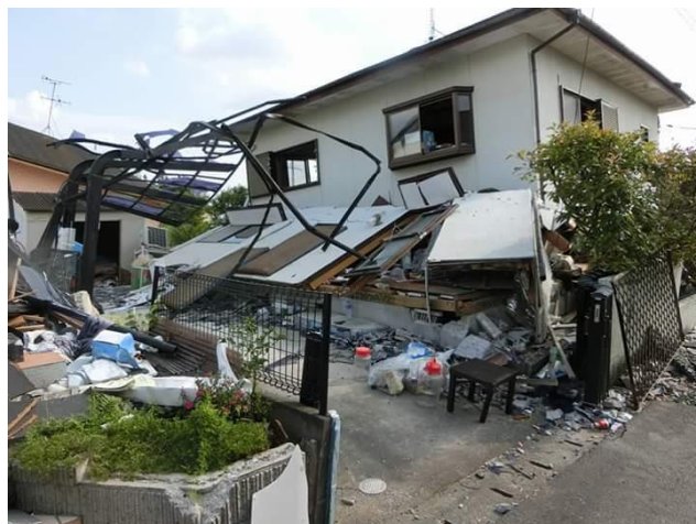
写真 1-2 熊本地震による被災状況 （平成28年熊本地震）
