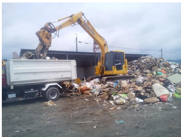
(重機による可燃物ごみ積み込み状況)
