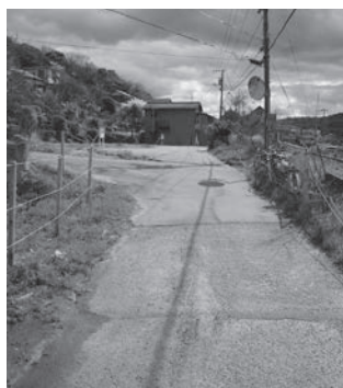
金山ニュータウン進入路周辺
