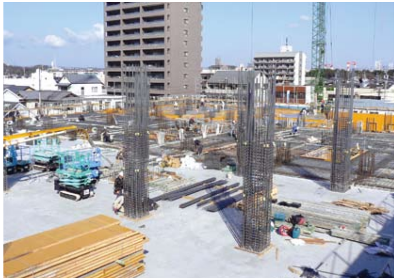
南東側からの工事風景
