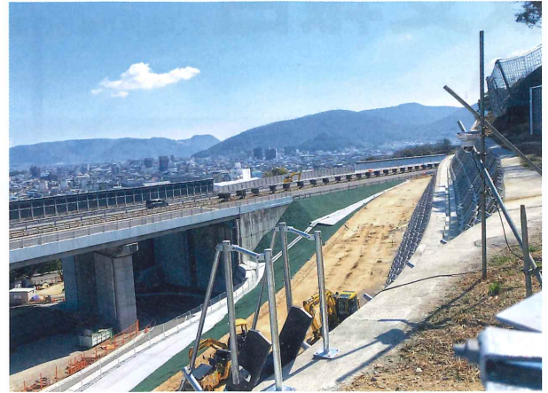
坂出北インターチェンジ(工事中)
