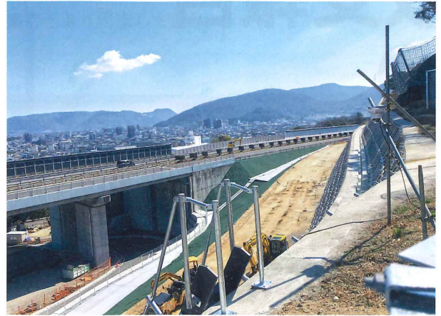
坂出北インターチェンジ(工事中)
