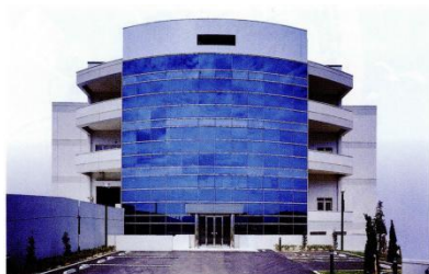
(写真) 坂出市リサイクルプラザ
