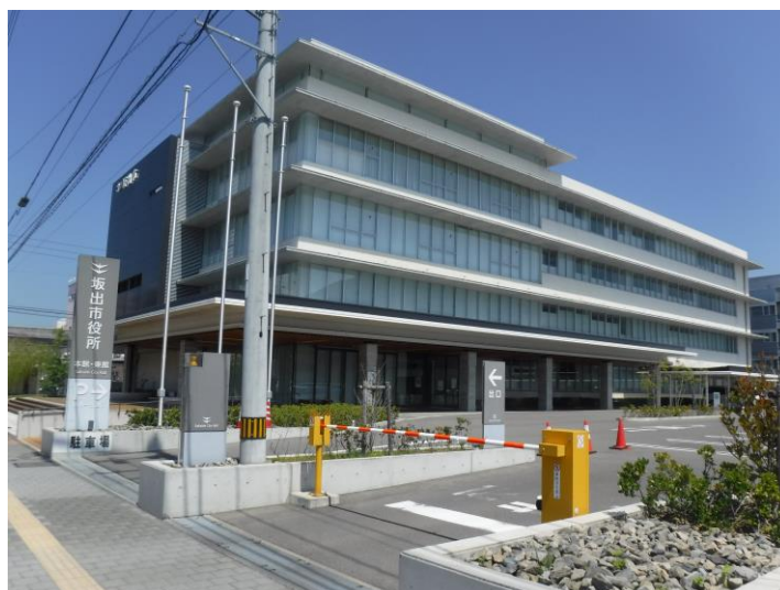
図 1-1 （写真）坂出市役所 庁舎
