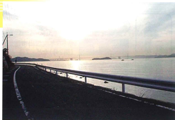
県道16号高松王越坂出線(拡幅前)
