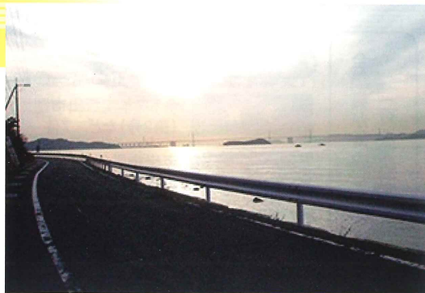
県道16号高松王越坂出線(拡幅前)
