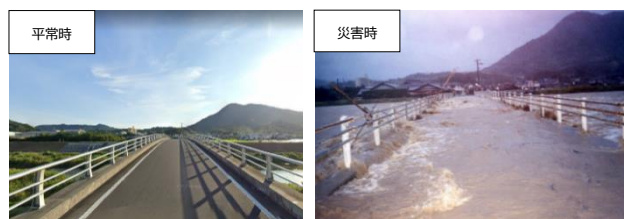
写真-2 平成16年台風第23号による被害 綾坂橋（府中町）
