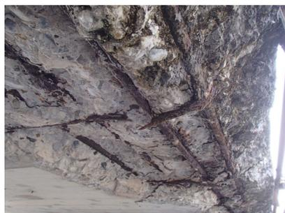
図 1.4 コンクリート橋の損傷例
