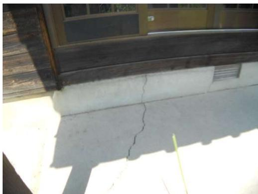
写真-⑲ 隣接閻魔堂におけるコンクリート基礎の亀裂
