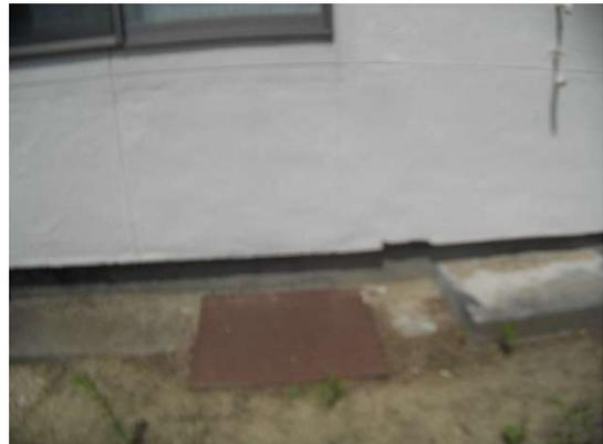
写真-⑯ 壁面モルタルの剥離、脱落
