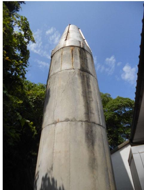
写真-④⑫ 集合煙突 亀裂が縦、横に発生している。
