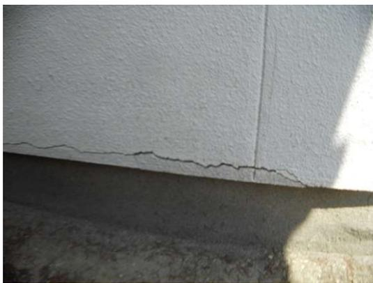
写真-⑰ 壁面モルタルの剥離、脱落
