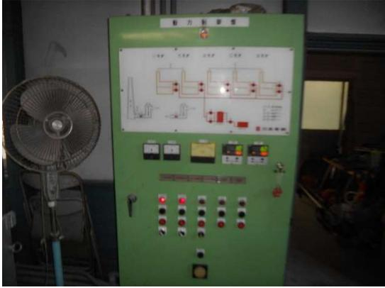
写真-③③ 動力制御盤
