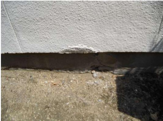
写真-⑮ 建物基礎コンクリートの劣化、
