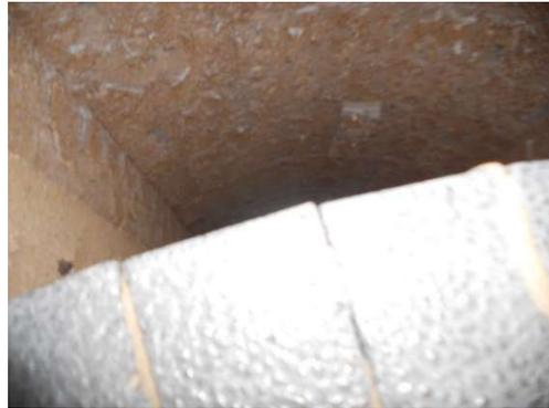
写真-25 支煙道内の耐火材の状況
