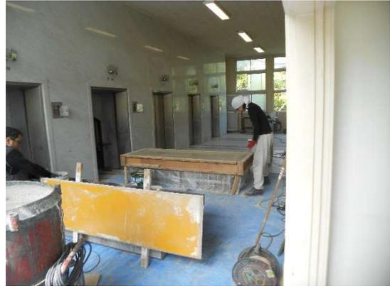
写真 - ⑩ 炉前ホール (い号、ろ号炉台車表面耐火材張替え中)
