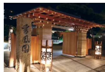
▲ 新設された西門
