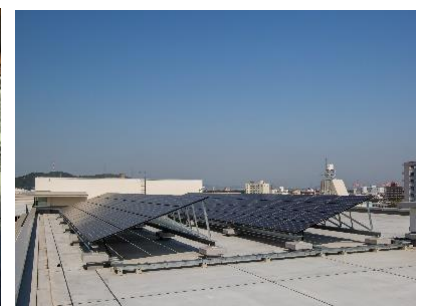
本庁舎への太陽光パネル設置
