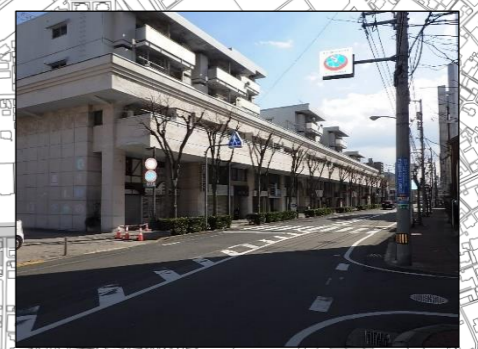
③ 坂出人工土地・市民ホール前
