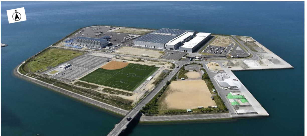
高松港香西（西）地区 H29.1.18 竣工
