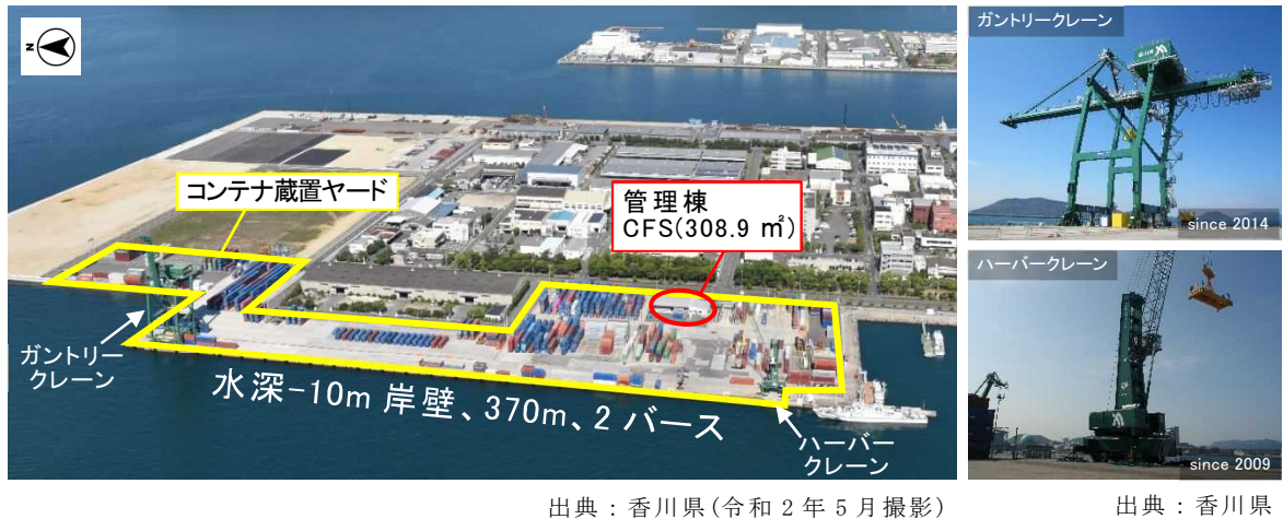
図表 1-36 コンテナターミナルの現況
