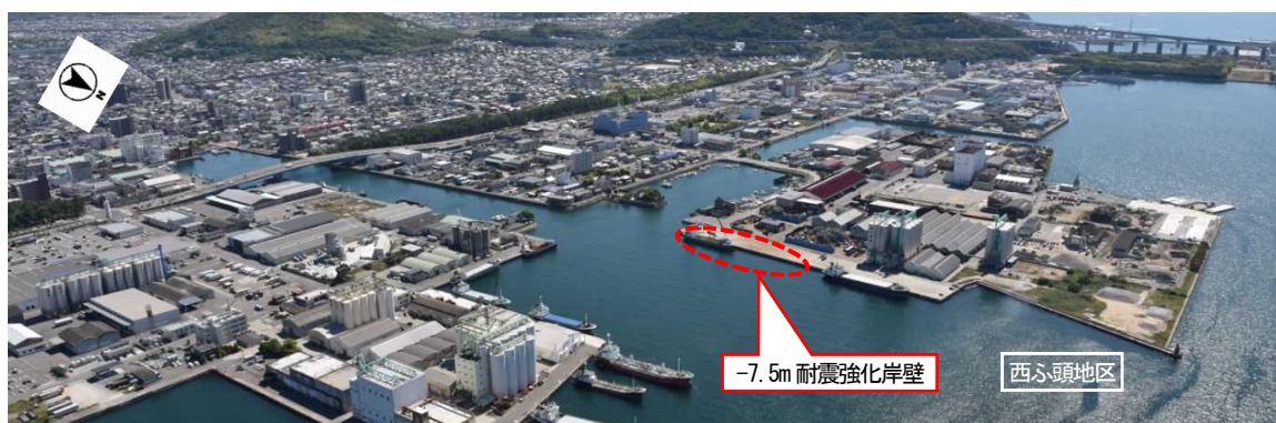
図表 1-69 坂出港の耐震強化岸壁
