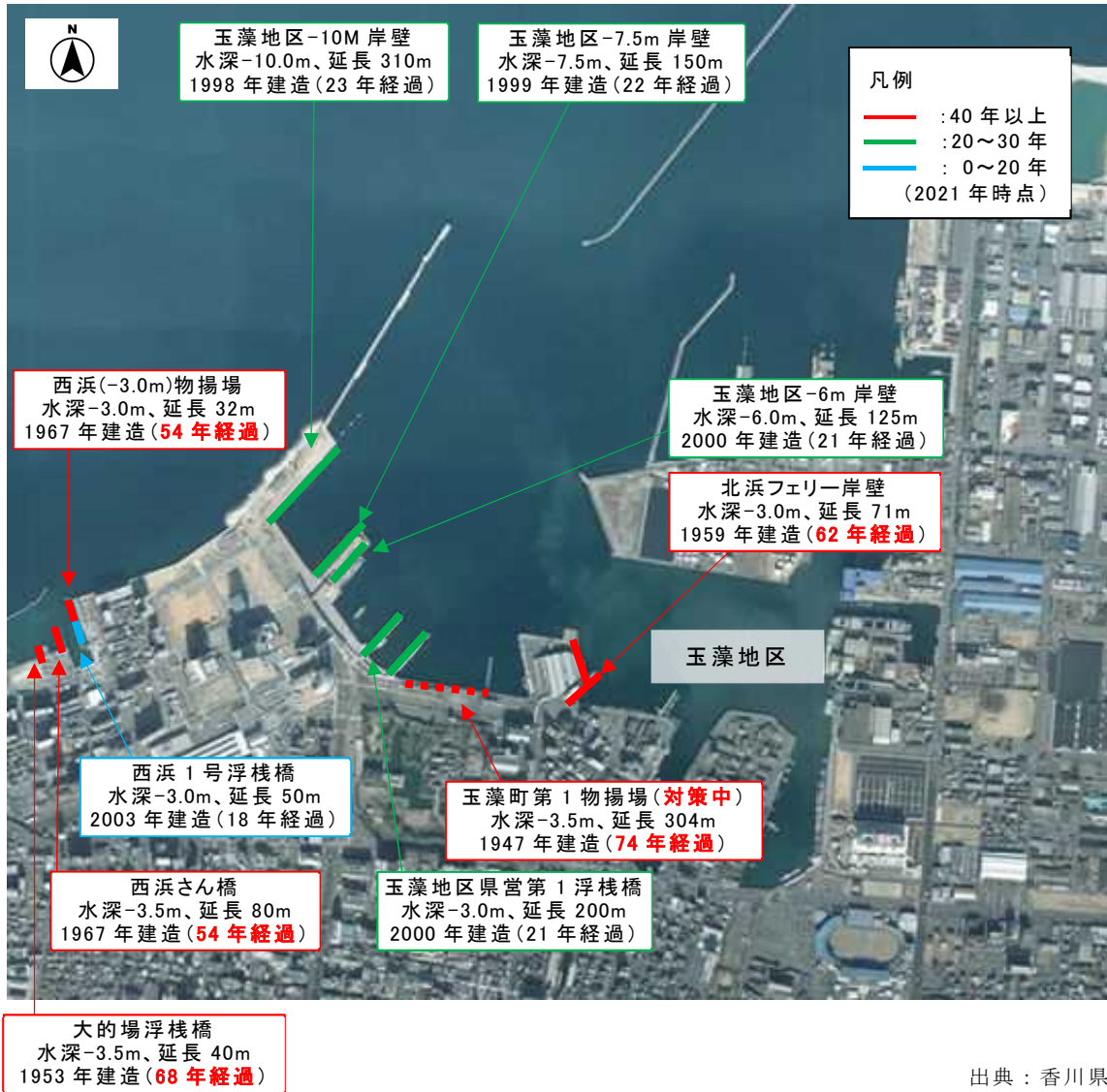
図表 1-55 港湾施設の老朽化（玉藻地区）
