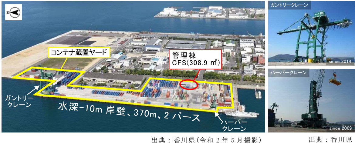
図表 1-36 コンテナターミナルの現況
