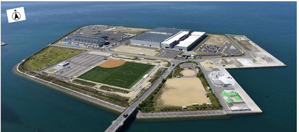
高松港香西（西）地区 H29.1.18 竣工
