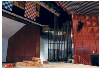
舞台の上にある装置は舞台右袖の引綱につながっています。
