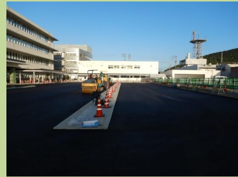
駐車場のアスファルト舗装です。
