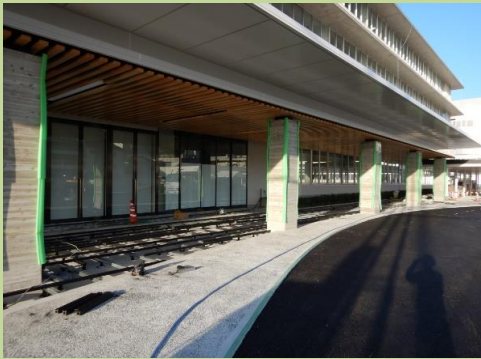
本館前の回廊(南側)が完成しました。
