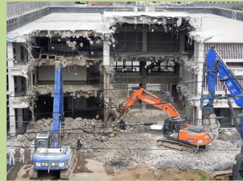
建物の解体は西側から進めています。
