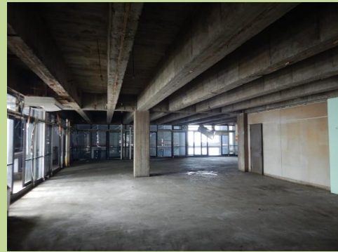
2階です。1階と梁の作りが違います。
