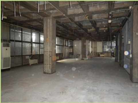
内装解体後の1階の様子です。
