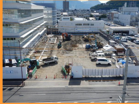
基礎も撤去し、旧庁舎の解体が完了しました。
