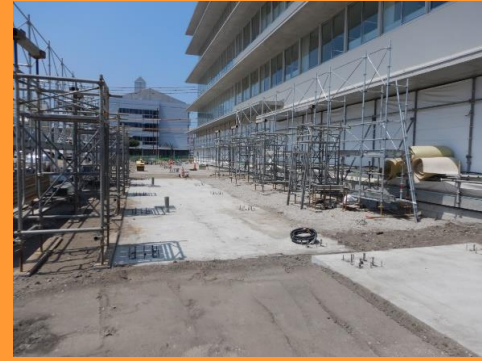
本館と東館とをつなぐ回廊の基礎です。
