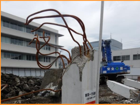
折れた柱から鉄筋の様子がわかります。
