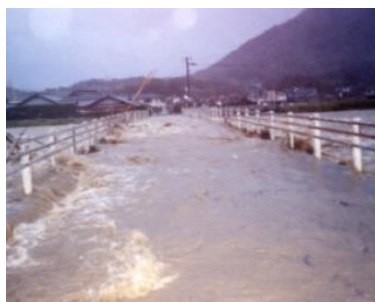
台風第23号洪水災害 綾川氾濫時の綾坂橋
