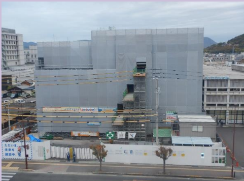
手前に張り出しているのは、部材の搬入口です。
