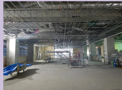
天井の下地が張り巡らされています。(1階)。
