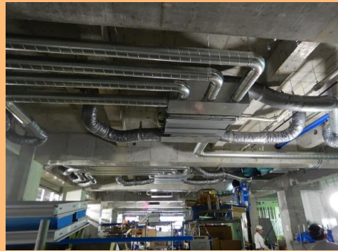
部屋の壁や配線等の内装工事が進んでいます
