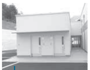
駐車場から車いすに乗ったまま施設内に入れるよう配慮された出入口
