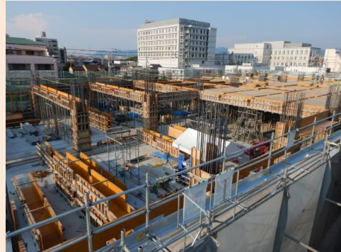
2階の柱が立ち上がっています。
