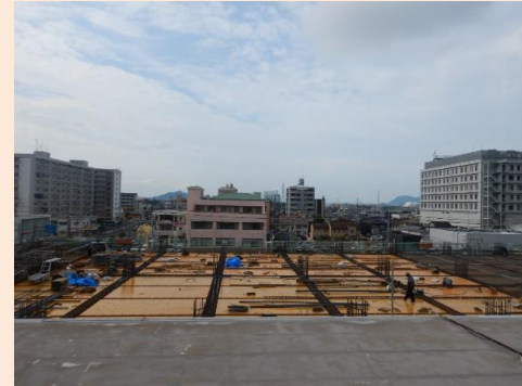
3階床現況。手前に見えるのは現庁舎の屋上です。
