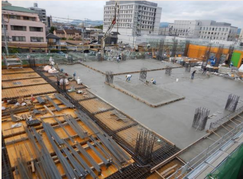
2階の床にコンクリートを流し入れています。
