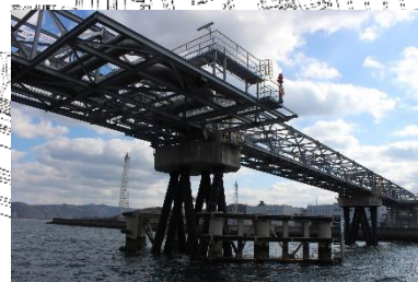
桁下から水面まで約12m
