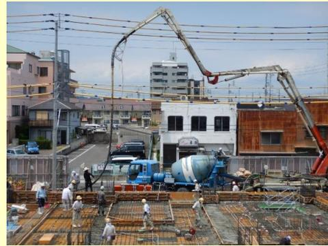
型枠で鉄筋を囲み、コンクリートを流し込みます。
