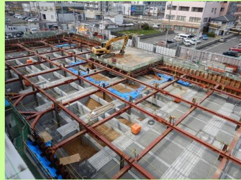
鉄筋を型枠で囲い、コンクリートを打設します。
