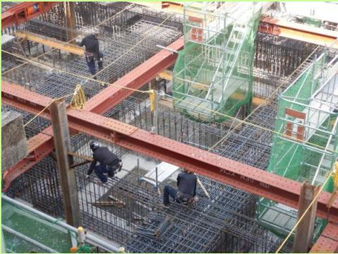
地下基礎部分の鉄筋を組みます。
