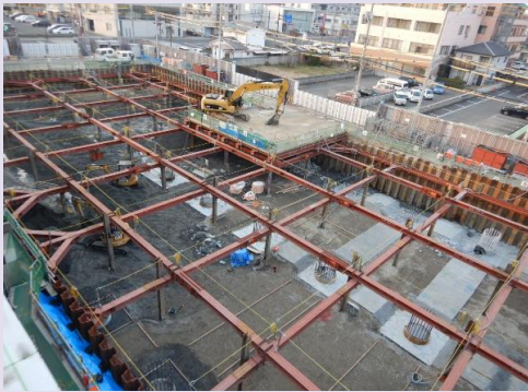
矢板固定のため鉄骨が張り巡らされています。
