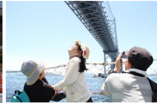
瀬戸大橋を見上げる
