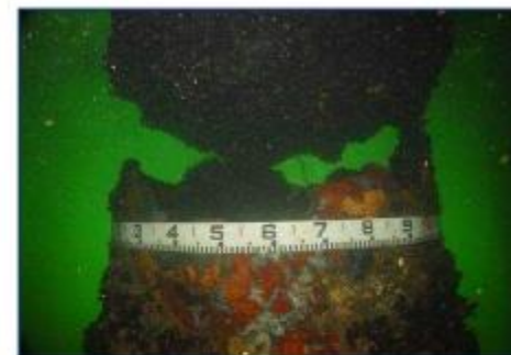
鋼管杭の腐食の進行による杭の破断
