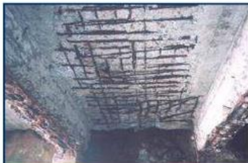
鉄筋の腐食によるコンクリートの剥離
