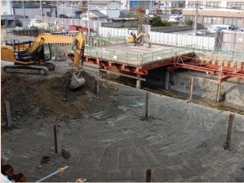
現地盤から約5mまで掘削していきます。
