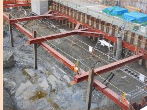
鋼矢板が倒れないよう鉄骨で支えています。
