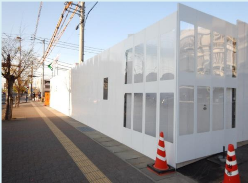
工事区域に仮囲いや足場が出来ました。
