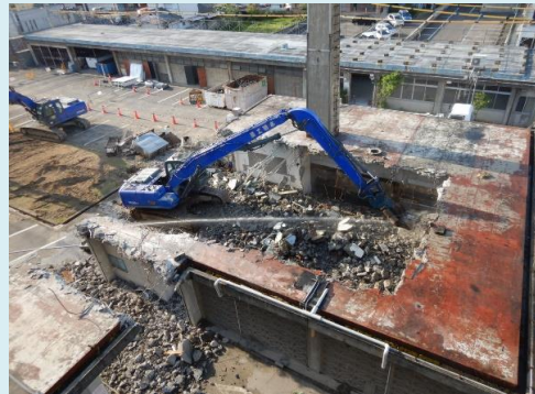
建物の解体が始まっています。
