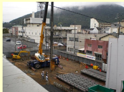
新倉庫を支える杭を打っています
