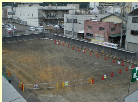
解体が終わり更地になりました
