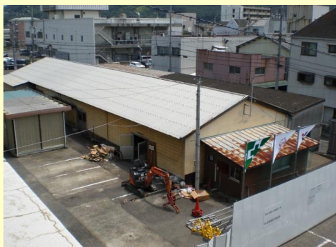
最初に着手するのは南倉庫の解体
