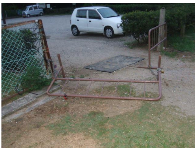
•強引な車両の侵入により破損した柵
