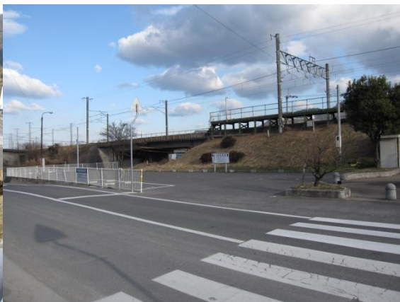
道側から見た駐車場(休日)
