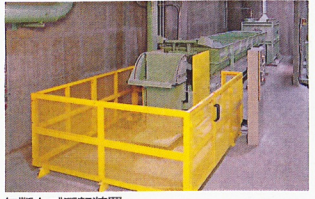
缶類カゴ反転装置 缶類の入った網カゴを反転し、カゴの中身を缶類投入ホッパに投入します。
