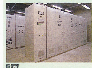
電気室 施設電力を一括して受電・変電・配電・制御しています。
