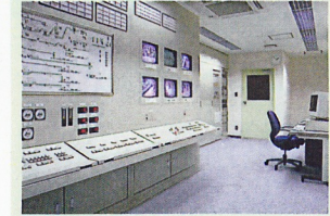
中央操作室 最新のシステムにより、主要設備は自動化が図られ、集中的に監視・制御できます。
