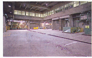
プラットホーム 搬入車の出入りと、危険物、不測物の除去作業が容易に行われるように、ゆとりあるスペースを確保しています。
