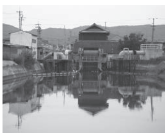
三七ポンプ場
