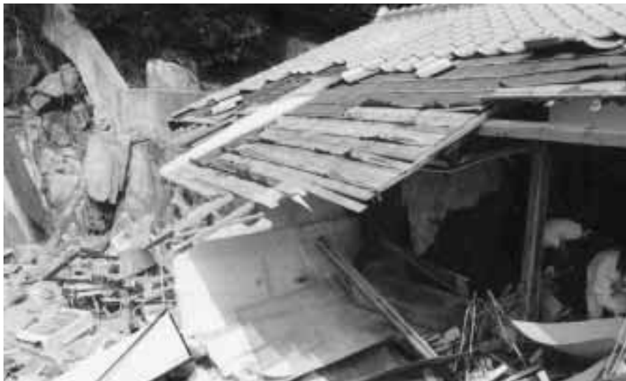
▲堤防を越えて民家を襲った高潮は家屋を全壊させた。(与島町)
