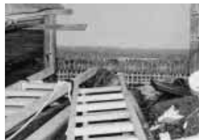
▲ガラスを破って海水が流れ込み、床上浸水した民家。海水が土壁の土を落とし、その跡が残っている。(櫃石島)
