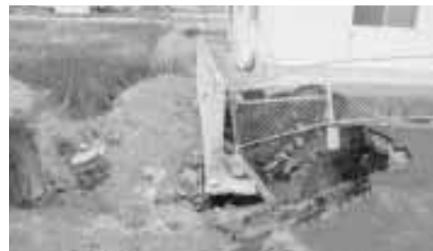
▲東運河から海水があふれ、堤防の裏側の土砂をさらって畑に流入した。(江尻町)
