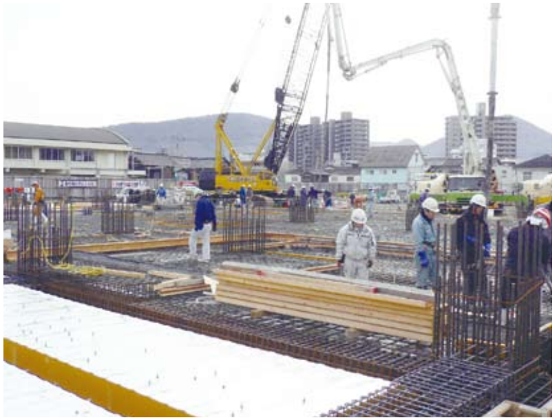
北西側からの工事風景
