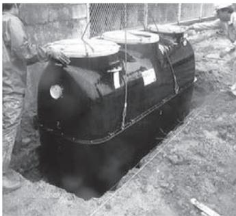
合併処理浄化槽
