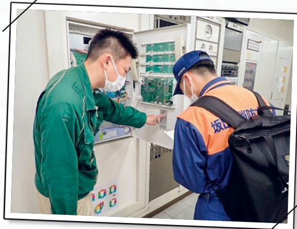
自動火災報知設備が正常に作動するか検査する様子
