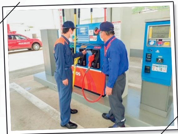
固定給油設備の動作確認の様子
