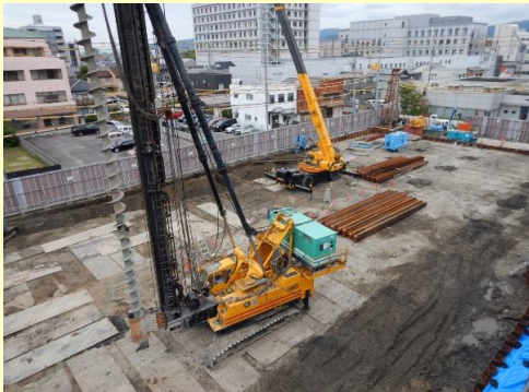
杭工事を終え、山留工事を進めています。
