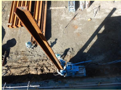
鋼矢板という11mの鉄板を差し込んでいます。
