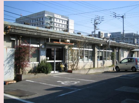
4月より北館の解体にかかります。
