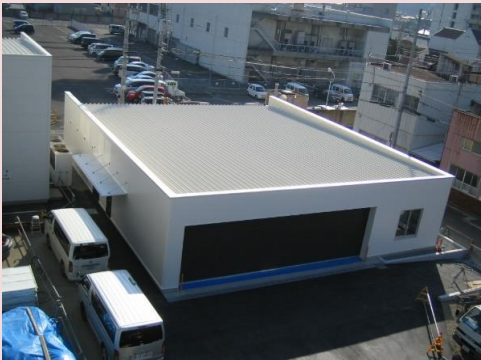
新倉庫棟が完成しました。
