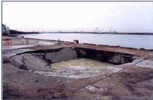
裏込め土の吸出しによるエプロンの陥没
