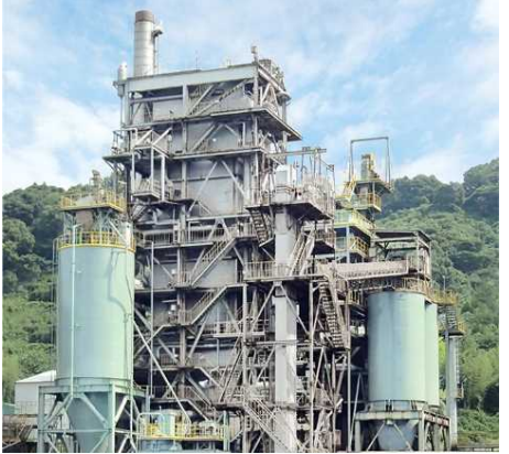
バイオマス発電所
